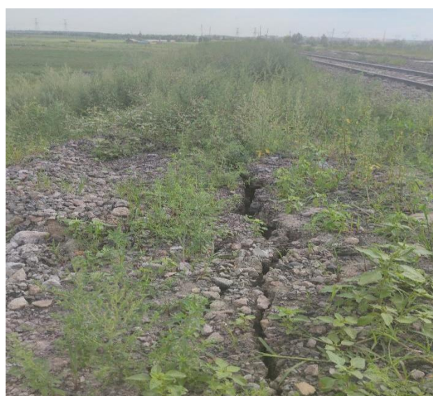
图 1-17 矿区自备铁路边坡地裂缝
