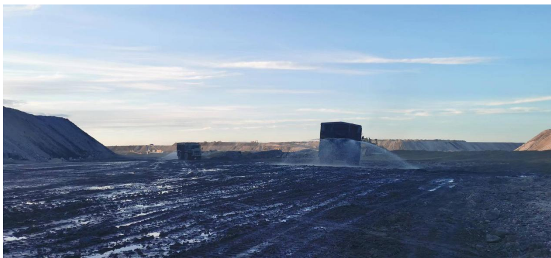
压灰排土场水车降尘现场图
