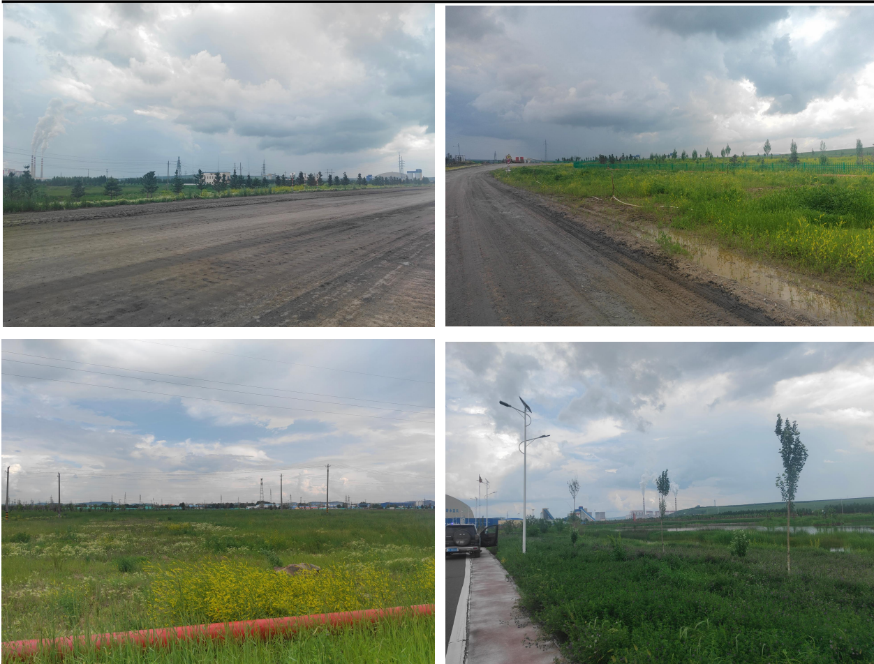
图 5 本项目现状照片
